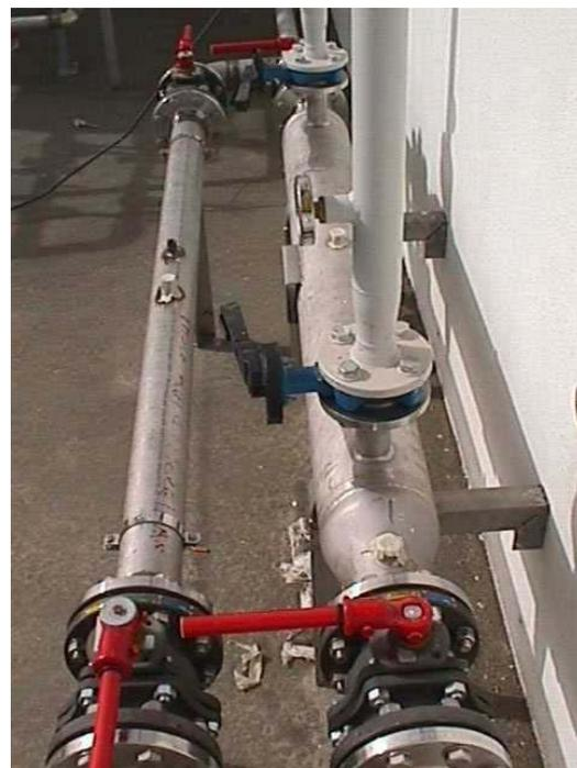
Fig. 2.68 – Permutador de calor de feixe tubular (sistema de vaporização misto) – Planta Satélite de Évora
