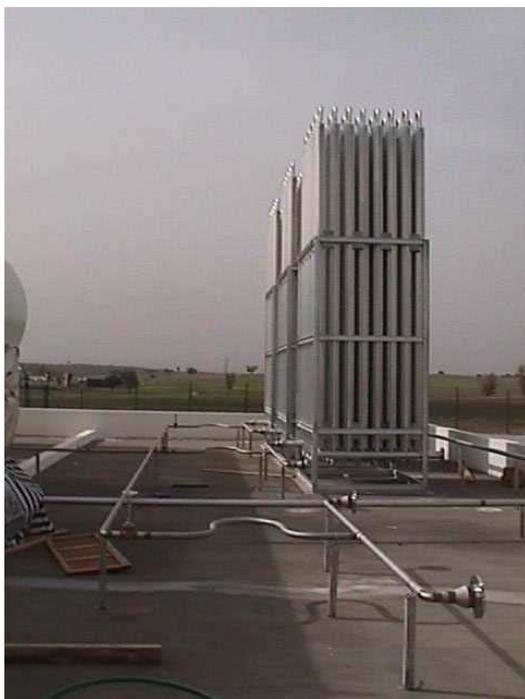
Fig. 2.67 – Bateria de vaporizadores atmosféricos (sistema de vaporização misto) - Planta Satélite de Évora
