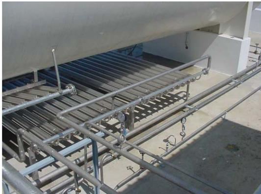
Fig. 2.78 – Vaporizador de descarga de cisternas (tipo I)
