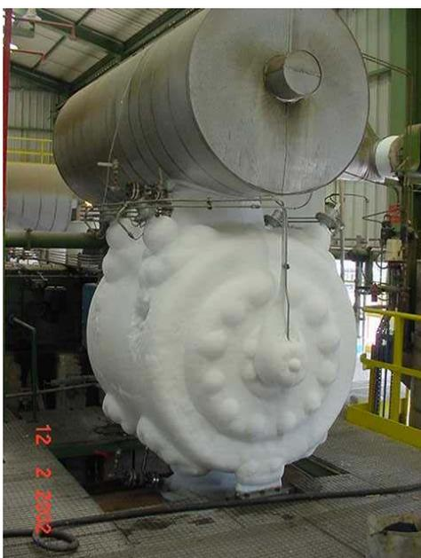
Fig. 2.19 – Compressor de vapores de GNL
