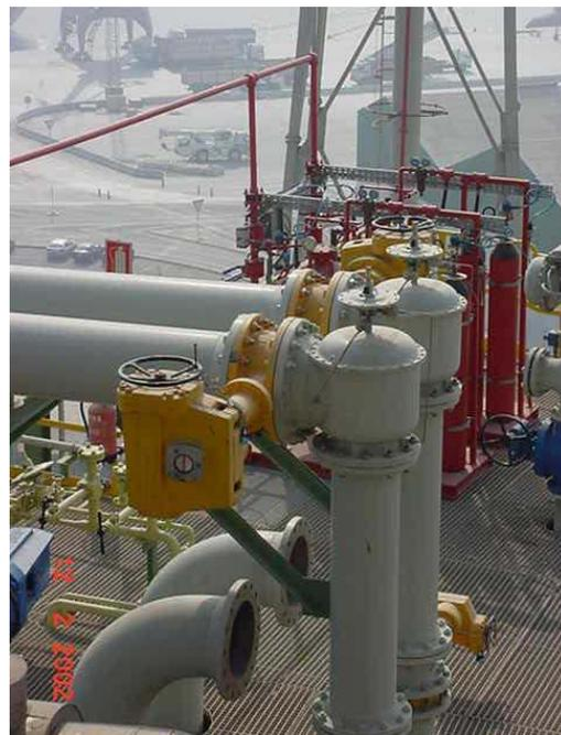
Fig. 2.15 – Válvulas de segurança contra sobrepressões
