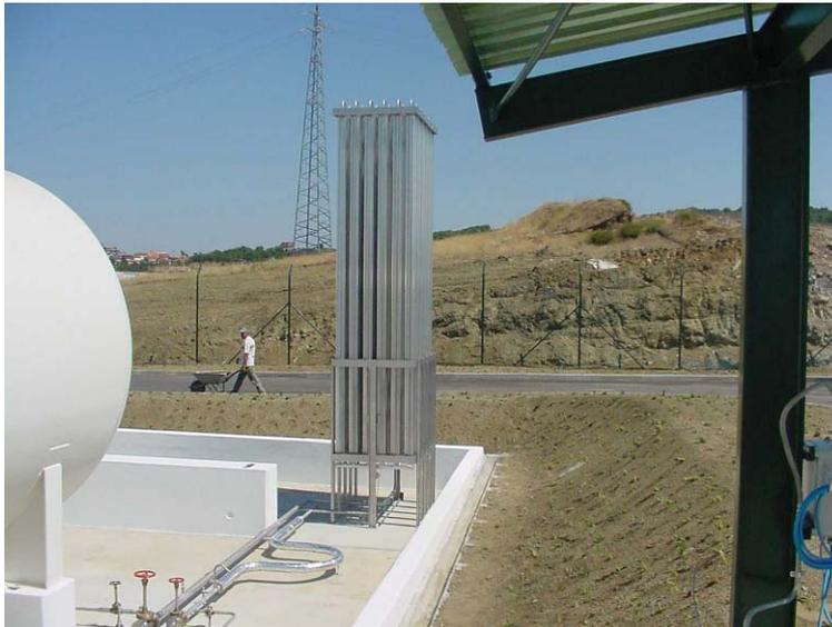
Fig. 2.63 – Vaporizador atmosférico de 700m<sup>3</sup>(n)/h – Planta Satélite de Bragança
