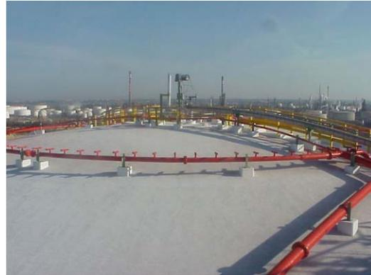
2.50 – Rede de combate a incêndios (cúpula de um tanque de GNL) – Terminal de GNL de Huelva
