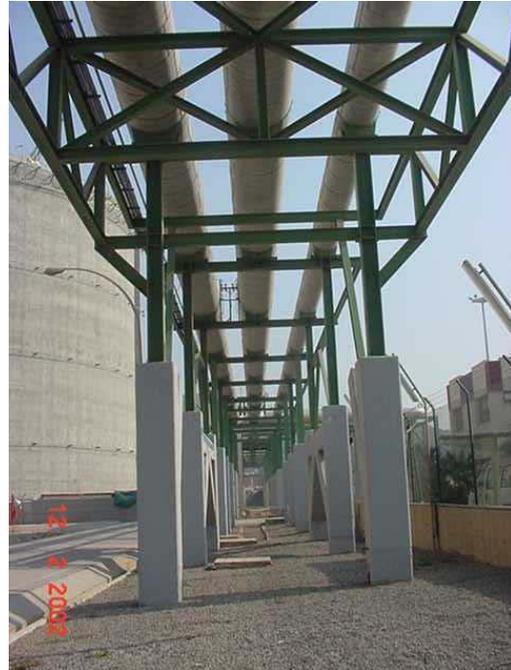
Fig. 2.38 – Elementos de suptagem de uma tubagem de GNL – Terminal de Cartagena
