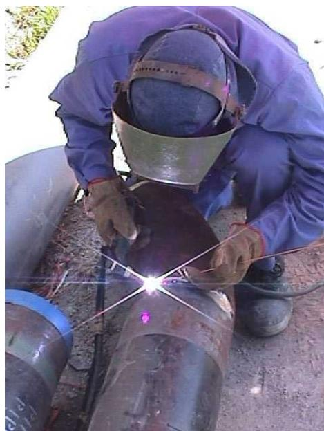
Fig. 2.83 – Soldadura topo-a-topo (rede primaria escalão) – Ramal de Vale de Cambra
