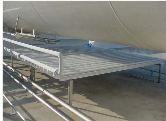
Fig. 2.56 – Permutador de calor atmosférico - Planta Satélite de Bragança
