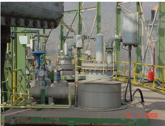
Fig. 2.21 – Poço de uma bomba primária submergível – Terminal de GNL de Cartagena
