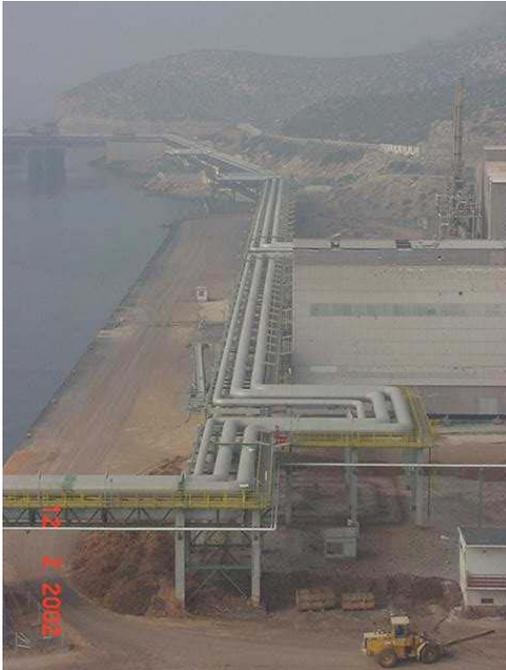
Fig. 2.37 – Compensadores de dilatação - Terminal de Cartagena
