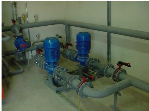
Fig. 2.66 – Circuito de bombagem de água quente
