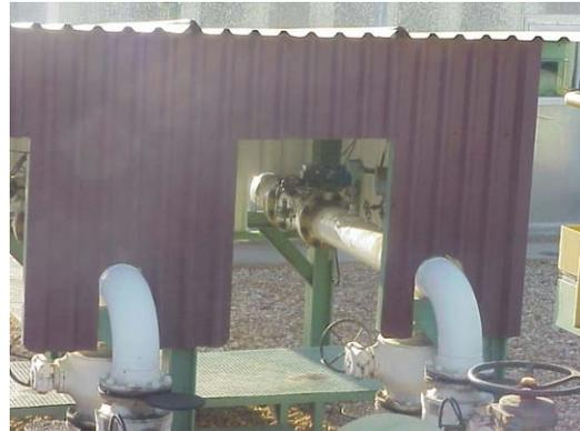
Fig. 2.42 – Pormenor do contador de turbina
