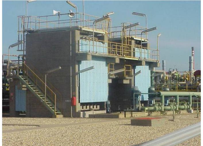
Fig. 2.26 – Vaporizadores de água de mar – Terminal de GNL de Huelva
