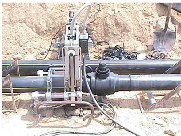
Fig. 2.85 – Soldadura topo-a-topo em tubos de polietileno
