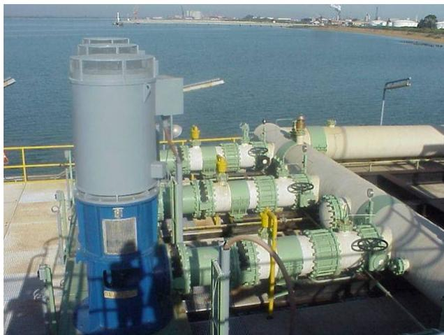
Fig. 2.27 – Bombas de captação de água de mar – Terminal de GNL de Huelva
