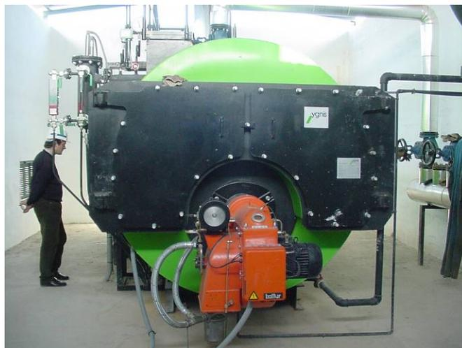
Fig. 2.87 – Gerador de Vapor a GN (convertido de fuelóleo)
