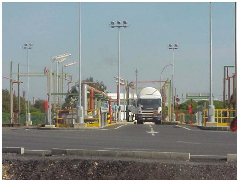
Fig. 2.57 – Enchimento de uma cisterna de GNL – Terminal de GNL de Huelva
