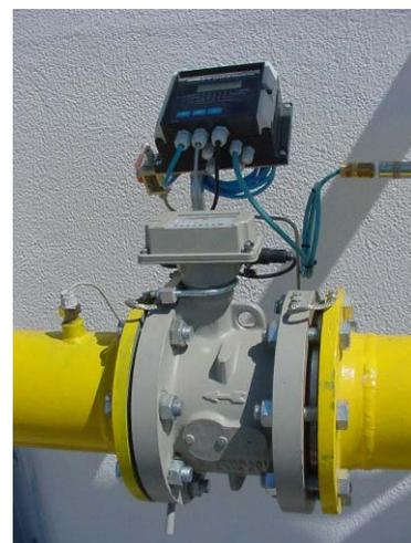
Fig. 2.71 – Pormenor do contador de turbina
