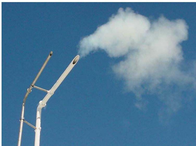
Fig. 2.62 – Descarga atmosférica de GN através de um vente - Planta Satélite de Olhão
