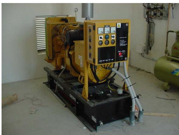
Fig. 2.77 – Grupo electrogêneo (de emergência) - Planta Satélite de Bragança
