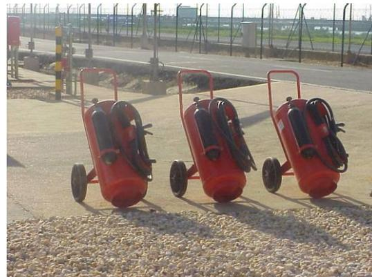
Fig. 2.52 – Extintores de pó químico – Terminal de GNL de Huelva
