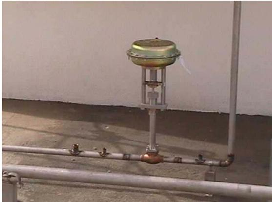
Fig. 2.74 – Válvula de seccionamento accionada pneumáticamente – Planta Satélite de Évora
