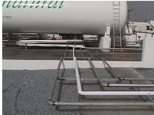
Fig. 2.79 – Linhas e vaporizador de descarga de cisternas
