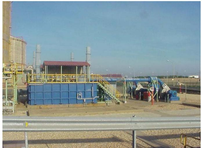
Fig. 2.29 – Vaporizador de combustão submersa – Terminal de GNL de Huelva
