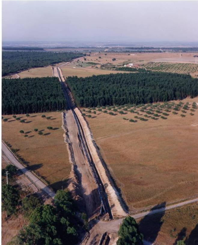
Fig. 2.80 – Vista aérea da construção de um gasoducto (rede primária de 1º escalão) – Lote 3
