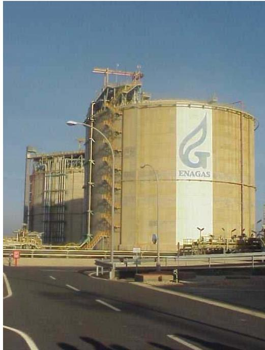
Fig. 2.11 – Tanques (autoportantes) de GNL do Terminal de Huelva
