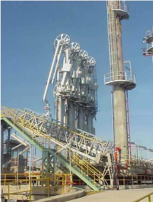
Fig. 2.31 – Braços de descarga – Terminal de GNL de Huelva
