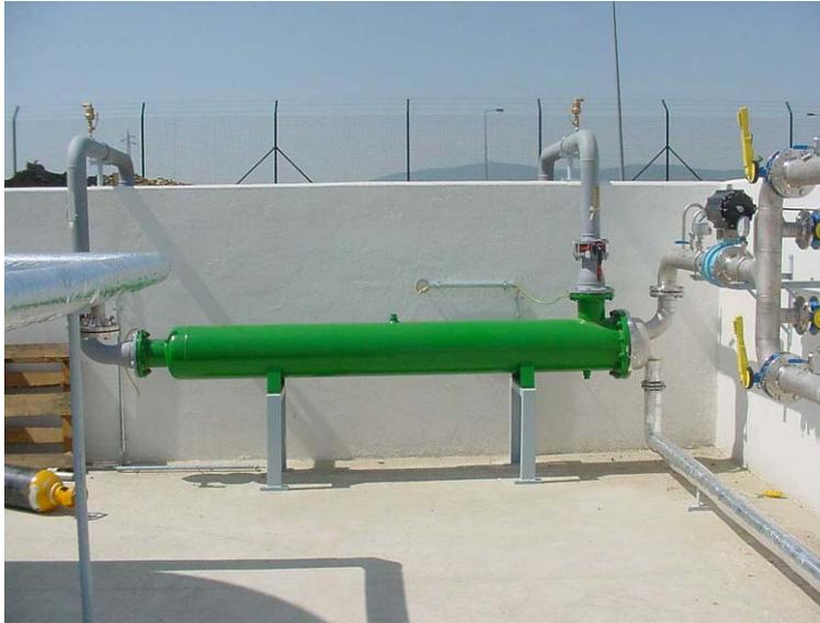
Fig 2.64 – Permutador de calor de feixe tubular de 3.000m<sup>3</sup>(n)/h - Planta Satélite de Bragança
