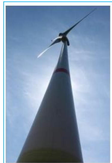
Windpower Installation Brenntenberg, 3.2 MW
